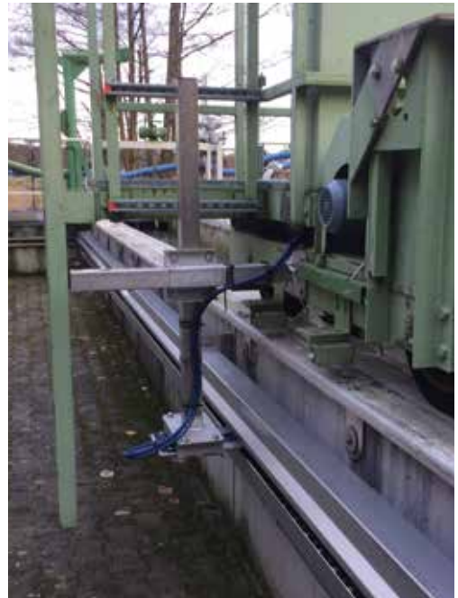
Sandfang mit teleskopierbarem igus® Mitnehmerarm Verfahrweg: 19 m
